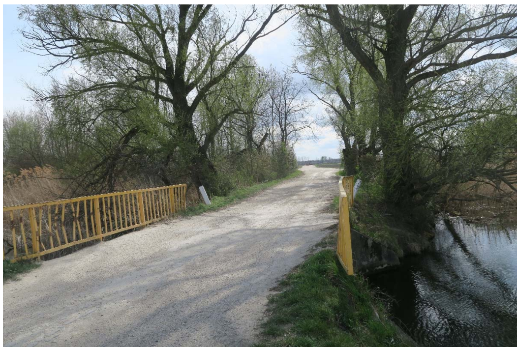
3. kép. Bácsai-csatorna kis hidja a mellette lévő fűzfák.
