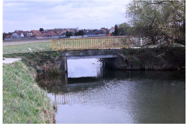
5. kép. A csatornán átívelő kis híd északnyugat felől.
